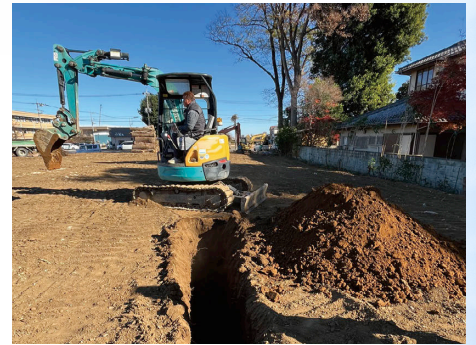
買取った土地の造成工事の様子
